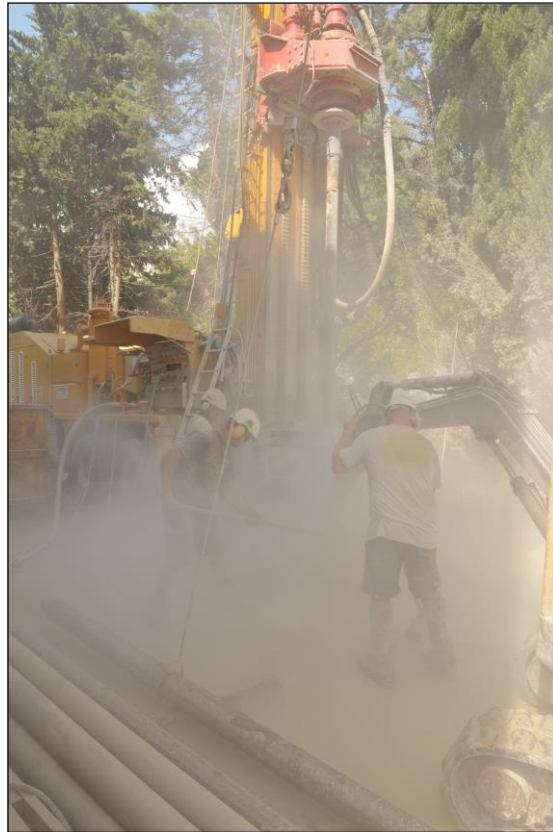
Photographie 2 : Foration au marteau
