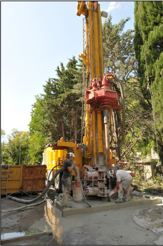
Photographie 1 : Foration au rotary
